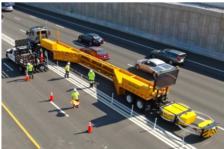
Rys. 6.6.8 Przykład funkcjonowania mobilnej bariery tymczasowej MTB w czasie pracy na drodze [48]
